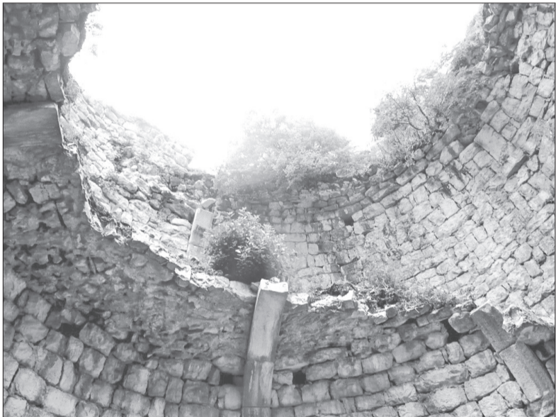
Верхняя часть башни со следами обрушения конструкций
