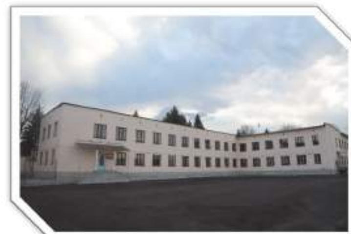
здание по ул. Эльбердова 47а
