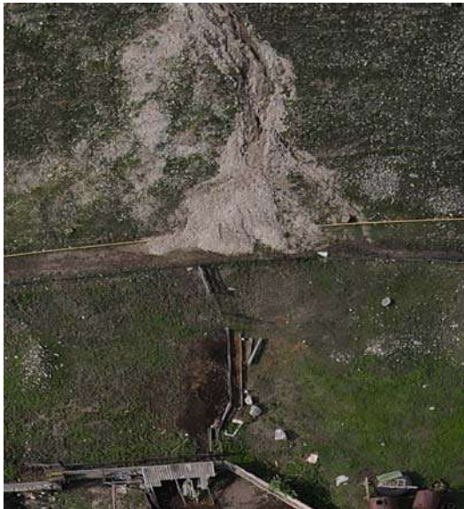
Рис. 2. Завал селевой массой трубы газовой магистрали села
