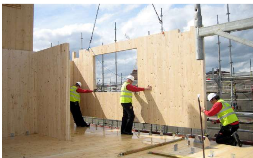
Рисунок. Процесс монтажа CLT-панели
