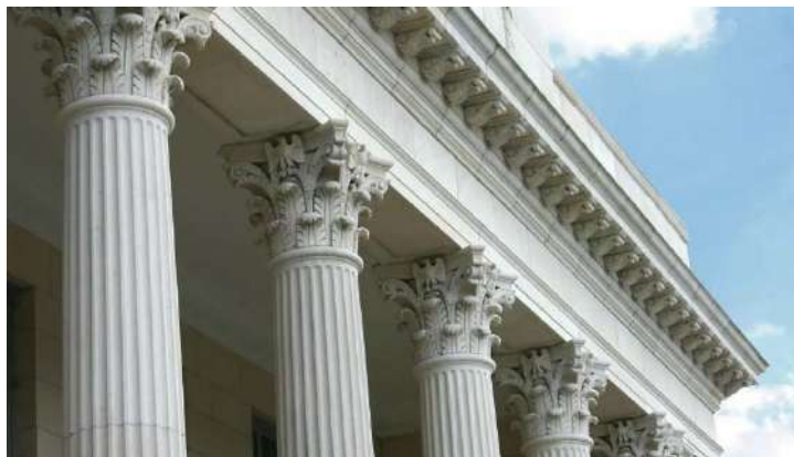
Рис.2. Пилястры на колоннах
