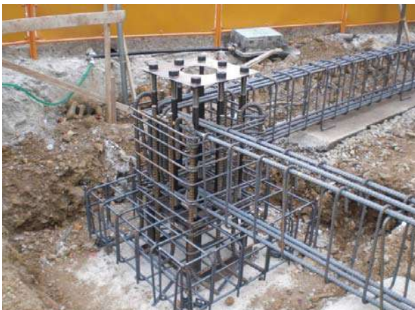
Рис. 1. Объемный арматурный каркас для монолитного ленточного фундамента
