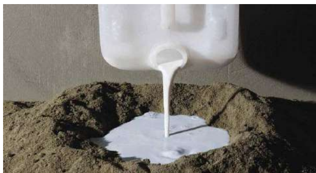
Рис. 1. Добавление модификатора/пластификатора в процессе затворения раствора
