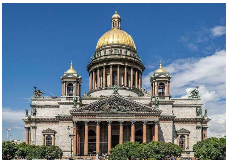
Рис. 1. Современный вид Исаакиевского собора [2]
