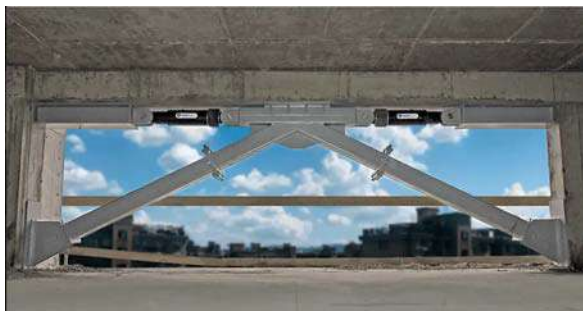
Рис. 2. Применение демпферов на основе вязкой жидкости в строительстве
